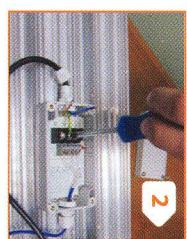
Подсоединить сетевые провода к клеммной коробке (диаметр провода не более 8 мм)
